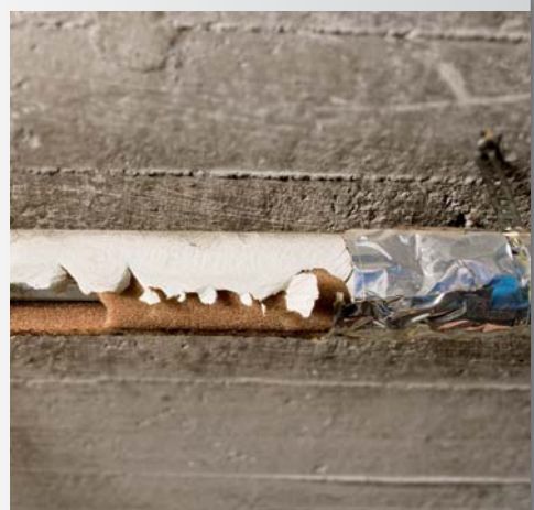
Defekte Rohrisolierung
