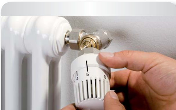
Prüfen der Voreinstellung an einem Thermostatventil
