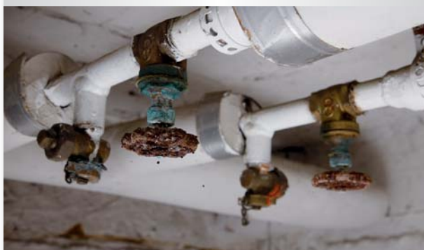
Fehlende Dämmung
