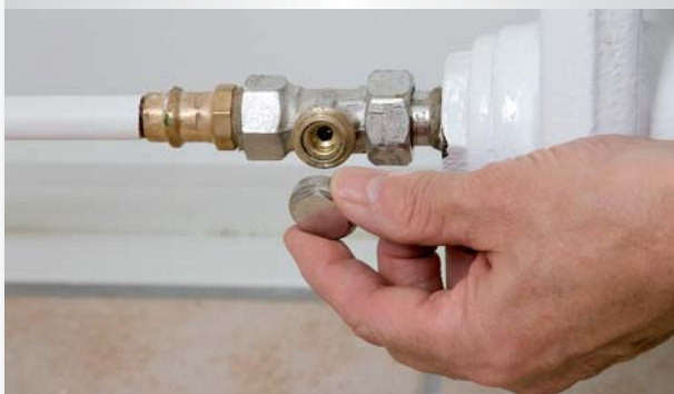
Prüfen der Voreinstellung an einer Rücklaufverschraubung
