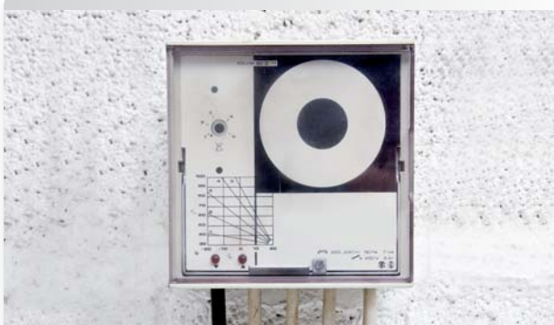
Außentemperaturgeführte Regeleinrichtung ohne Zeitsteuerung
